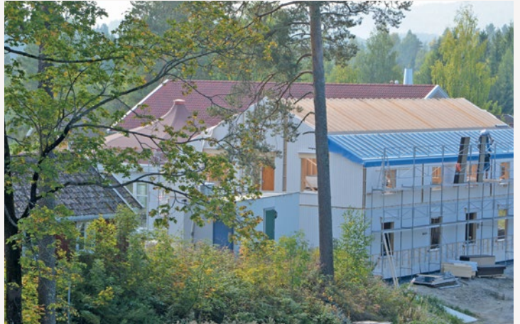
Det nye overnattingsbygget ved Kildehuset skal stå ferdig sommeren 2015.
