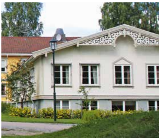
Slik så administrasjonsbygget ut før det fikk en ekstra etasje. Nå har det blitt 17 nye kontorer i den nye etasjen.
